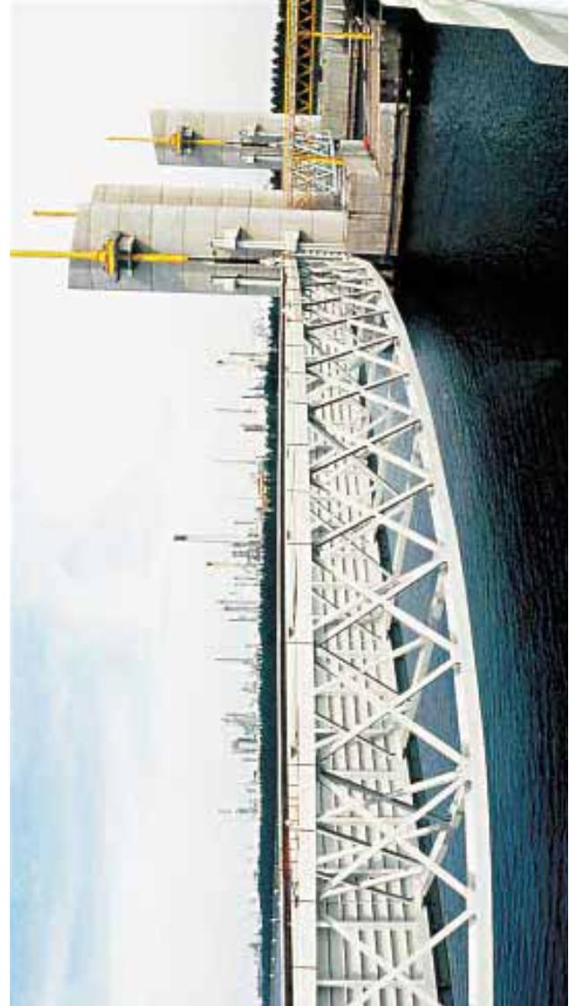
▲ Schutz für das Hinterland: Aus der niederländischen Fertigung stammen die je 30 Meter langen und 70 Tonnen schweren Hydraulikzylinder, an denen die Tore des Wehrs am Hartelkanal aufgehängt sind. Ausgefahren erreichen die Zylinder eine Länge von 50 Metern – immer dann, wenn sich das Wehr absenkt, um das Rotterdam Hafengebiet und das Hinterland vor Sturmfluten zu schützen.
