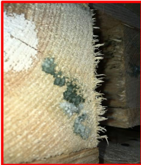
**Abbildung 15:** N.i.O. Schimmel, Schwamm, Trockenfäule
