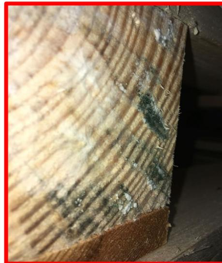
**Abbildung 20:** N.i.O. Schimmel, Schwamm, Trockenfäule
